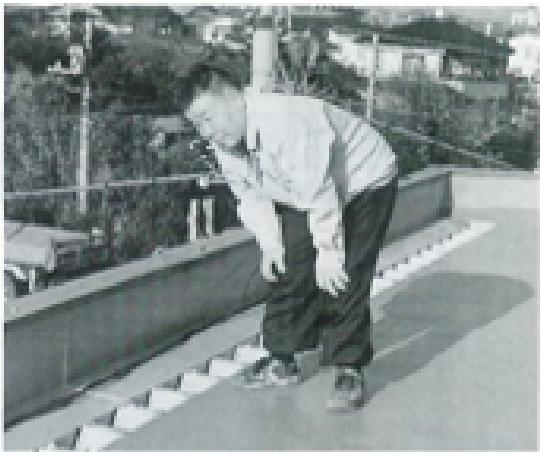
結露防止工事で折板屋根の上にFRP防水を施工し、仕上がり状態を確認する。
